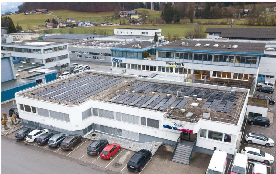
Auf rund 2000 Quadratmeter Dachfläche hat die Druckerei Roser 2019 zwei PV-Anlagen mit zusammen 150 kW<sub>peak</sub> Leistung installiert, die rund 40 Prozent des Strombedarfs abdecken.
